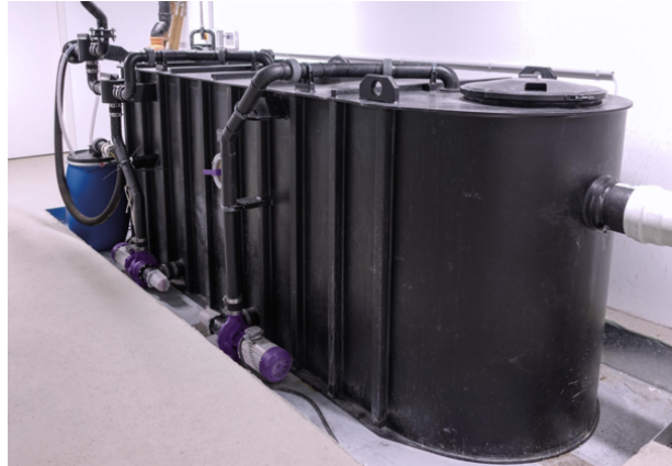
Der Fettabscheider EasyClean free Auto Mix & Pump NS 20 Selbstentsorger ermöglicht das Ablassen des Fetts in Sammelbehälter. (Quelle: KESSEL)
