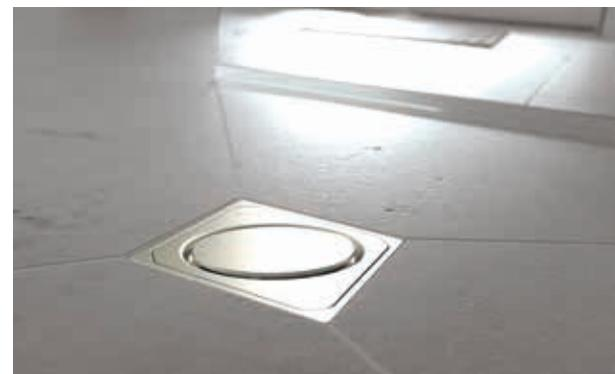
Einbaubeispiel Bodenablauf *Ecoguss* mit *Variofix*-Dünnbettaufsatz und Designrost *Oval*
